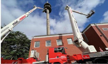
Arbeiten an einem Mobilfunkmast erfordern LKW-Arbeitsbühnen im Doppelpack
