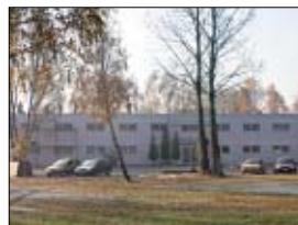
...und hier ist schon die neue Ansicht der (fast fertigen) polnischen mateco-Zentrale.
