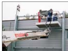
Die Renovierungsarbeiten am Bürogebäude in Tychy gingen sehr zügig vonstatten...
