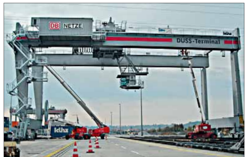
Flexibilität am Containerbahnhof: Der normale Betrieb lief trotz des Einsatzes von mateco weiter. Eine logistische Höchstleistung aller Projektpartner.
