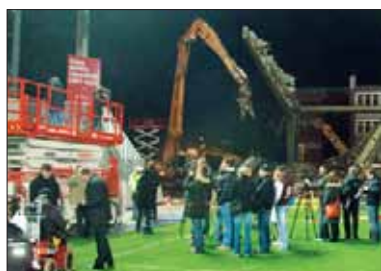
Beeindruckende Party zu Beginn der Bauarbeiten für die neue Haupttribüne.
