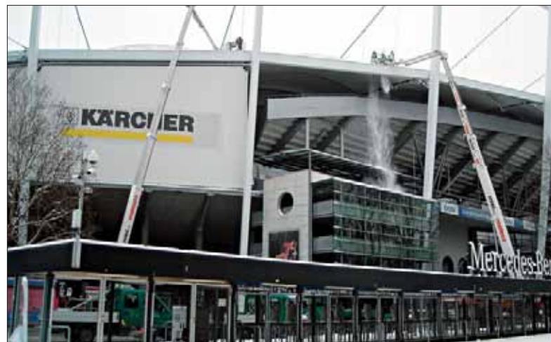
Mehrere LKW-Arbeitsbühnen rückten an, um das Stadion von Schnee zu befreien. Besonders knifflig war der Einsatz, da die Gefahr des Schneebbruchs bestand.
