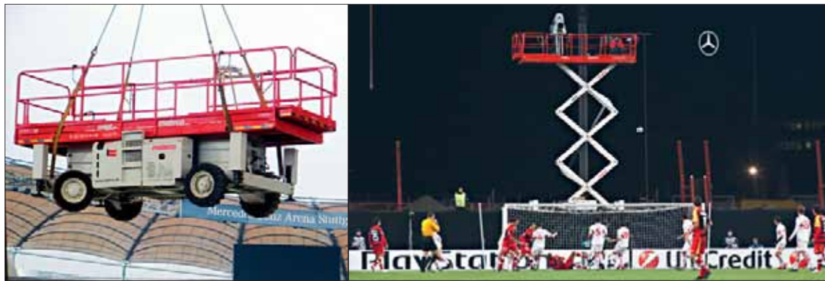
Die Scheren-Arbeitsbühne von mateco wird per Kran in die Baustelle gebracht, um Platz für die Hintertorkamera zu bieten und den Zuschauern auch weiterhin spannende Fußballbilder zu liefern – trotz des Umbaus an der Untertürkheimer Kurve.
