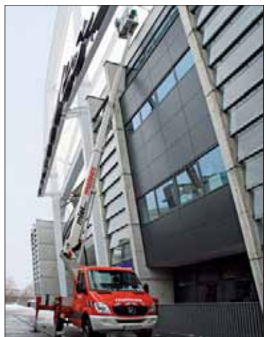
Vorsicht bei der Arbeit: Das Stadionsdach durfte nicht beschädigt werden.
