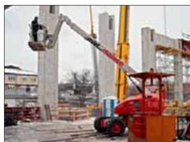
Enge Räume kennzeichnen das Bauvorhaben am Löwentor.
