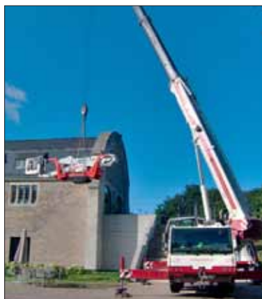
Per Kran wird die Extra-Arbeitsbühne auf den Vorplatz des Bahnhofs gebracht.
