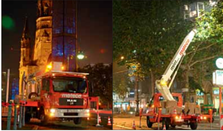
Über 750 Einsätze realisierte mateco zusammen mit Boehlke Elektroinstallationen in diesem Jahr, um die festliche Weihnachtsbeleuchtung in ganz Berlin anzubringen.
