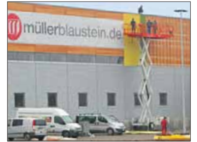
Ein Spezialgerät am Bau: die S 120 Diesel-Allrad Superdeck.
