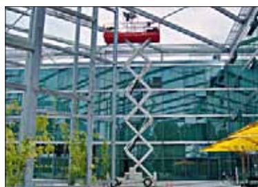
Die mateco S 180 D an der Freien Universität in Berlin im Einsatz.
