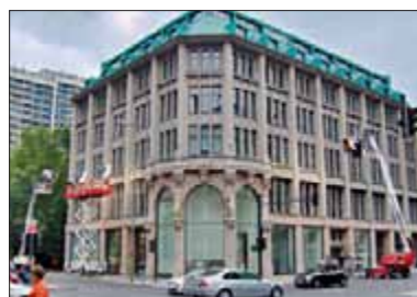
Einsatz an einer der elegantesten Adressen Berlins: mateco am Tuteur-Haus.
