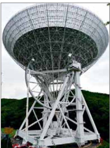
Reinigungsarbeiten am Radioteleskop in Bad Münstereifel.
