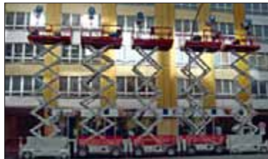
Fünf elektrobetriebene mateco-Scheren-Arbeitsbühnen auf nur 17 Meter Länge.
