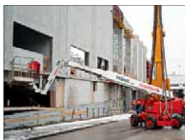
Wichtig: Das Ein-/Auskranken der mateco-Arbeitsbühnen musste möglich sein.
