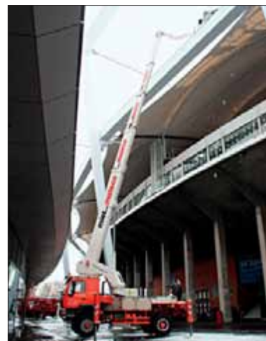
An mehreren Stellen gleichzeitig wurde der Schnee mit Hilfe von mateco entfernt.
