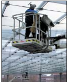
Vom Arbeitskorb aus waren die Glas-elemente sicher und einfach zu reinigen.
