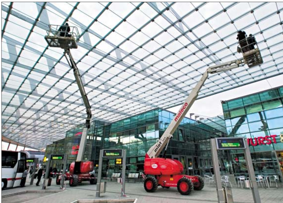
Das freitragende Glasdach des Zentral-Omnibus-Bahnhofs wurde mit der Kombination TG 264 K D 4x4 und T 221 K D 4x4 gereinigt.
