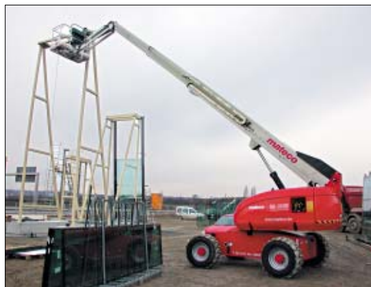
Die T 203 K D 4x4 überzeugte bei Montagearbeiten auf der neuen Landesmesse.
