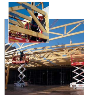
Die Dachholzkonstruktion konnte von den Monteuren in kurzer Zeit installiert werden.
