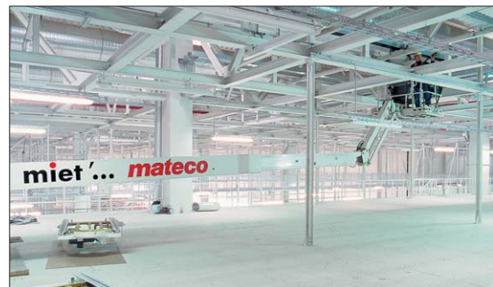
Für die wenig tragfähigen Zwischenböden bot die Teleskop-Gelenk-Arbeitsbühne TG 264 KD 4x4 S die optimale Lösung.
