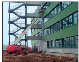
Sicheres Abfahren der Außenfassade des Gebäudes mit Allrad-Teleskop-Arbeitsbühnen.
