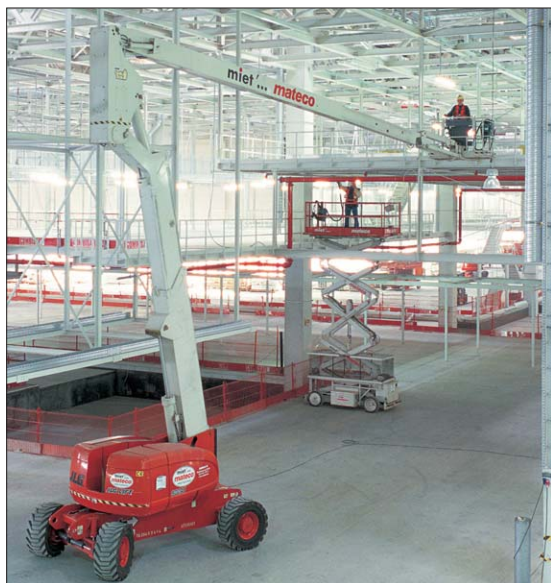
Neben den Spezialgeräten kamen auch unterschiedliche Scheren-Arbeitsbühnen zum Einsatz.
