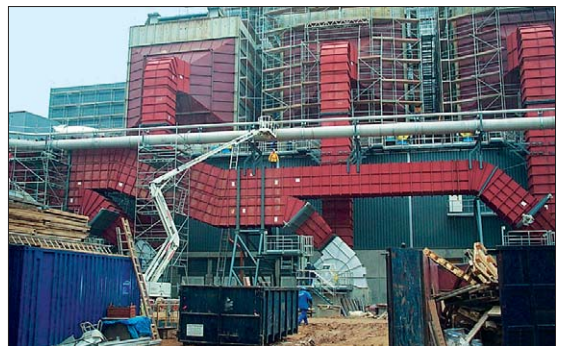
Das streckenweise verwinkelte Rohrleitungssystem war nur mit den großen Teleskop-Gelenk-Arbeitsbühnen zu erreichen.
