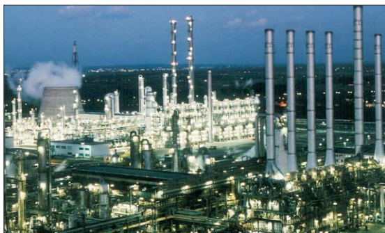
Blick auf die Olefin-Anlage im Werk Scholven. Ein verwinkeltes Leitungssystem und deren hochsensibler Inhalt erfordern höchste Ansprüche an die Zugangstechnik.
