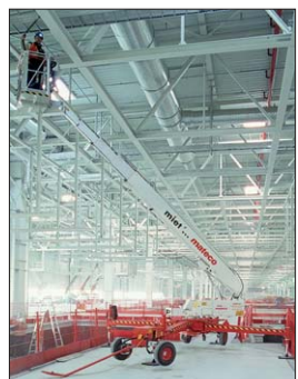
Die Extra-Arbeitsbühne XT 280 E kam überall dort zum Einsatz, wo eine geringe Durchfahrtsbreite von min. 0,91 m und eine Arbeitshöhe von bis zu 28 m gefragt war.
