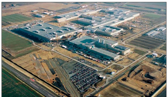
Rund 5.500 Mitarbeiterinnen und Mitarbeiter werden künftig im neuen BMW Werk Leipzig einen dauerhaften Arbeitsplatz finden.
