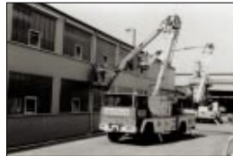
Dachrinnenarbeiten: LKW-Gelenk-Arbeitsbühne mit Korbarm und 27 m Arbeitshöhe, Numela Skylift/Magirus.
