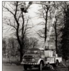
Baumschnittarbeiten: LKW-Gelenk-Arbeitsbühne mit Korbarm und 21 m Arbeitshöhe, Numela Skylift/Mercedes Benz.
