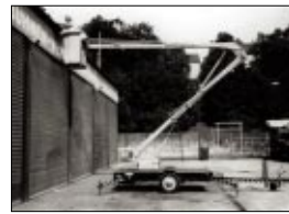
Fassadenarbeiten mit der Anhänger-Gelenk-Arbeitsbühne, 13 m Arbeitshöhe, Eurofit.
