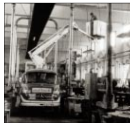
Instandhaltungsarbeiten: LKW-Gelenk-Arbeitsbühne, 11 m Arbeitshöhe, Ruthmann/Mercedes Benz.
