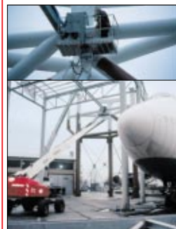
Noch wartet der Jumbo auf die Montage seiner Stahlstützkonstruktion.
