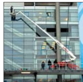
Bei der Reinigung der Glasfassade der AOL-Arena kam nur die XT 222 in Frage.
