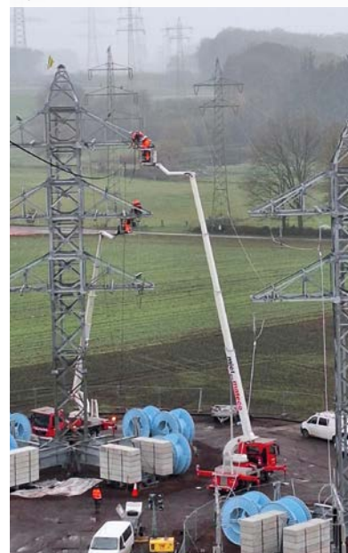
In der Nähe von Osnabrück wurde mit unseren zwei LT 330 K D an Freileitungen gearbeitet.
