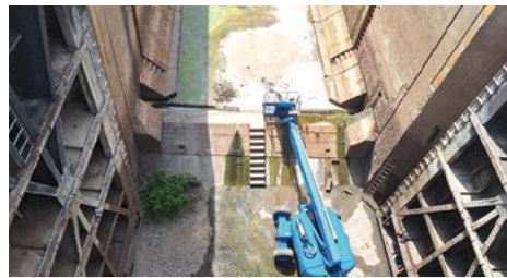
Für Reparaturen wurde unsere Teleskop-Arbeitsbühne mithilfe eines Krans in die Schleusenkammer gebracht.
