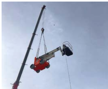
Mithilfe eines Krans wurde die Teleskop-Arbeitsbühne zum Einsatzort gebracht.
