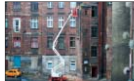
In der Armii Krajowejstraße wurde eine neue Etagensheizung eingebaut.
