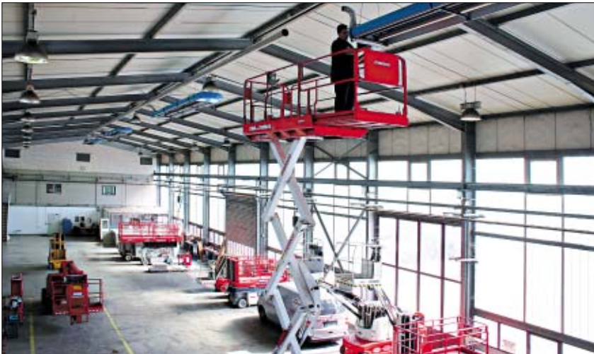
Arbeiten an der neuen Hallenheizung – mit der modernen Kübler-Infrarot-Technik wird mateco künftig sehr viel Energie sparen können.
