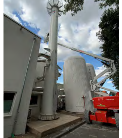
Anbringung eines Graffitis an der Fassade des neuen Blockheizkraftwerks in Wernigerode.
