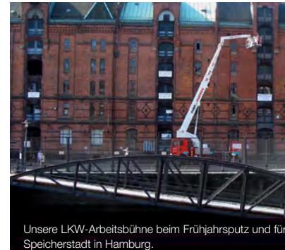
Unsere LKW-Arbeitsbühne beim Frühjahrsputz und für Wartungsarbeiten in der Speicherstadt in Hamburg.
