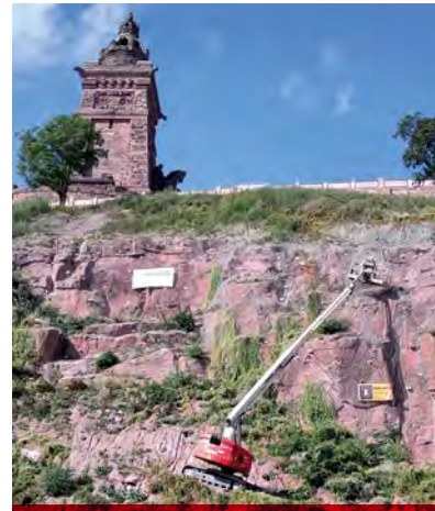
Anbringung eines Steinschlagschutznetzes im Harz am Kyffhäuserdenkmal.
